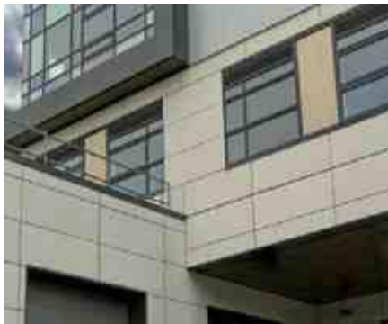
4- شكل الواجهه النهائي بعد تركيب ال ال grp
