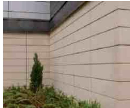
5-شكل الواجهه النهائي بعد تركيب ال ال Grp
