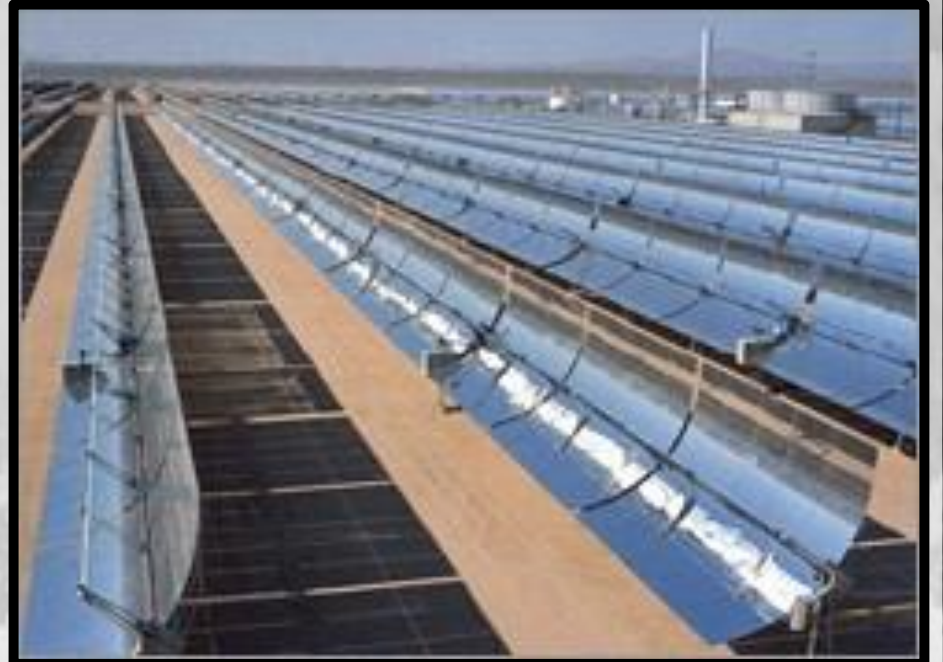
محطه تعمل بمرايا القطع المكافئ المستطيليه
