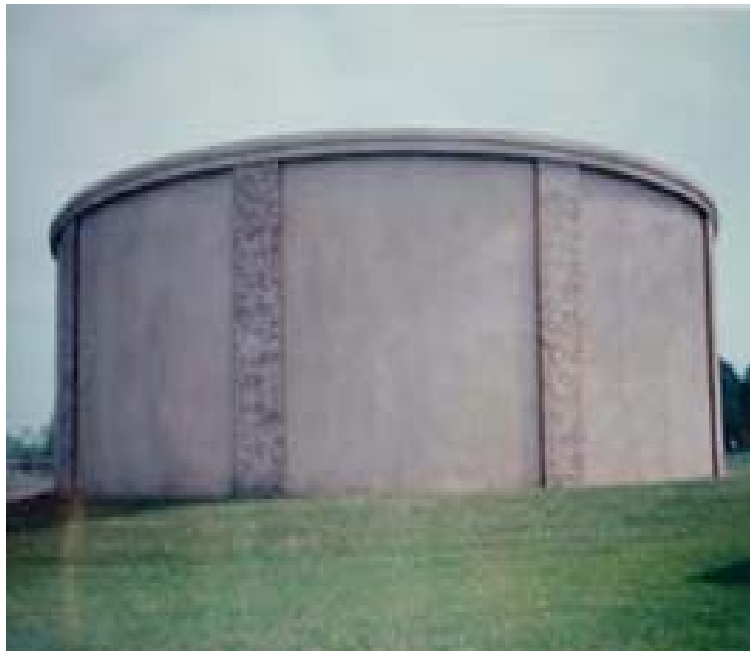
شكل (٩,٢): خزانات منشأة من الخرسانة المسلحة.
